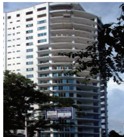
Многоквартирный дом в городе Санто Доминго, Доминиканская республика. Перекрытия выполнены из опалубки P&GG® Metal .
