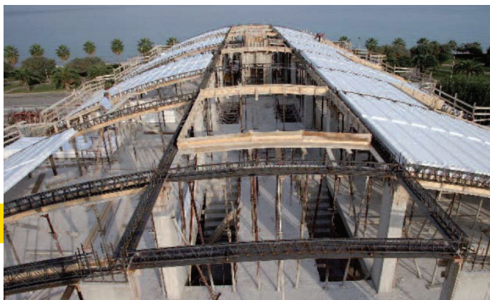
Кровля поомышленного здания на Сицилии. Выполненная из изолирующей опалубки P&GG® .
