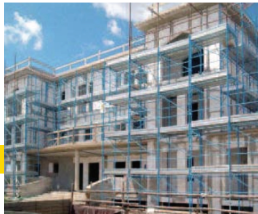
Строящаяся гостиница, Козенца. Пилястровая констоукция и ж/бетонные балки.
